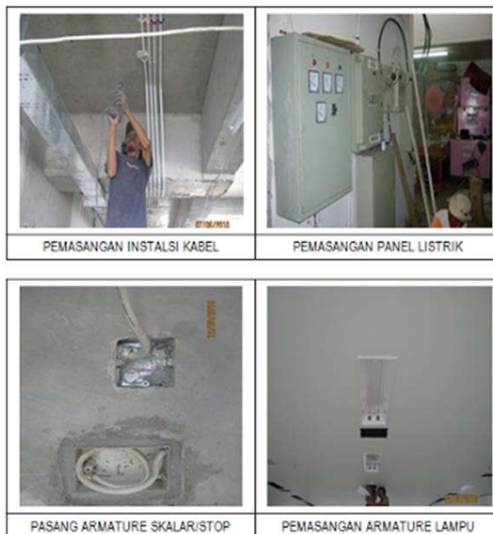
Gambar 4. Pekerjaan Elektrikal Arus Kuat dan Arus Lemah
